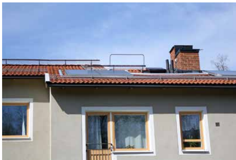
Solfångarna på Alice Tegnérsväg i Tullinge byts nu ut mot hybridpaneler som inte bara ger vattenburen värme utan även el.
