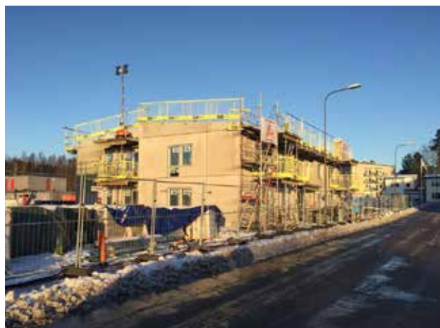
72 nya hyresrätter är under uppförande i Riksten, Tullinge.
