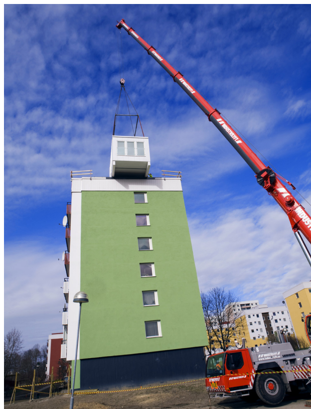
En av takvåningarna i Alby Etage lyfts på plats.
