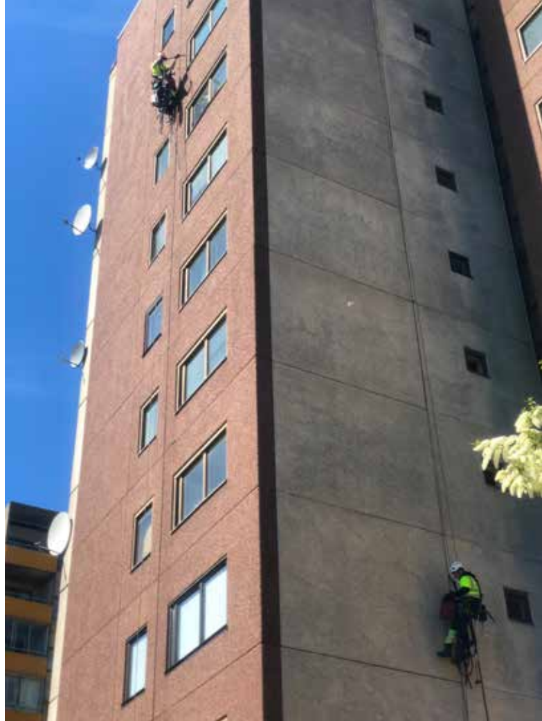
Fasadtätning pågår i Fittja.
