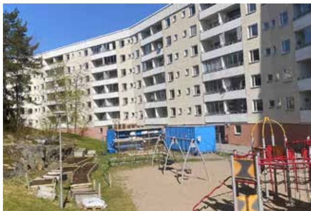
Stambyte pågår på Passvägen i Storstvreten.
