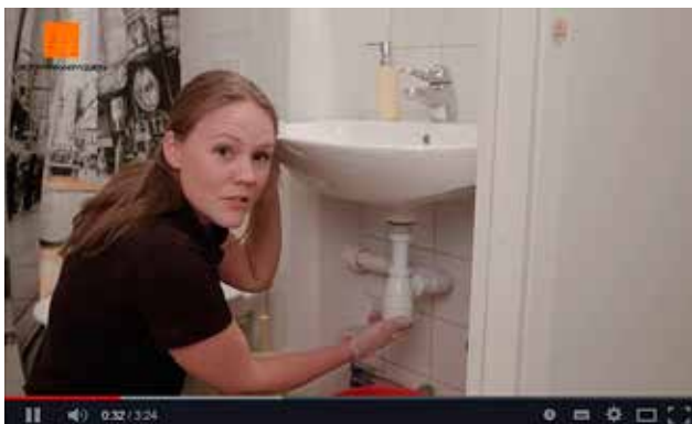
Reparatören Maria berättar om hur hyresgästerna själva kan lösa problem med stopp i avloppet.
